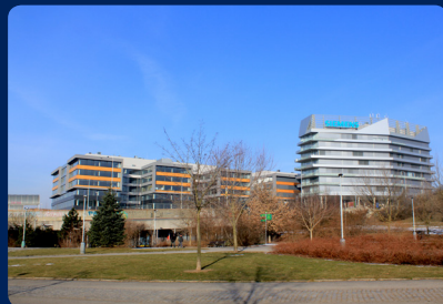
Siemens Praha - nové sídlo GEGE pExtra
